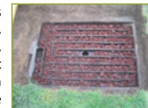
Filtre à cheminement lent après nettoyage et remplacement du matériau filtrant
