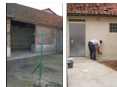
Création d'une réserve pour la bibliothèque de Saint-Erme : chappe, fondation, construction de murs, isolation, création et pose de porte et fenêtre.
